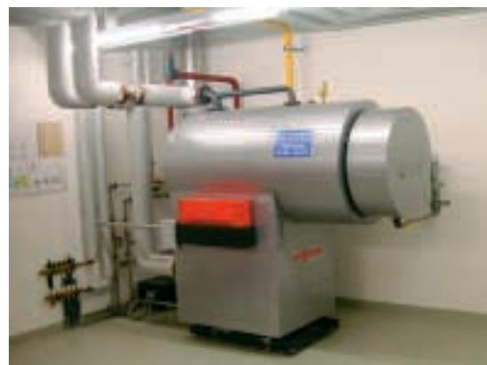
Brennwert-Gasheizkessel Vitocrossal, mit modulierendem Matrixbrenner.
