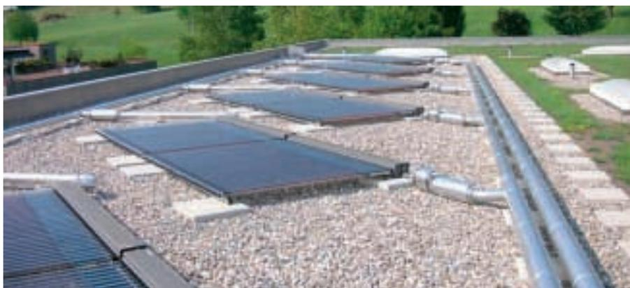
Vakuum-Röhrenkollektoren Vitosol, diskret auf Flachdach montiert.
